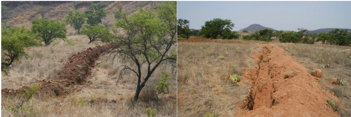
Figura 5. Zanjas de infiltración y plantación de magüey mezcalero. Rancho Dolores, Huajuapán de León, Oaxaca. Mayo de 2010.
