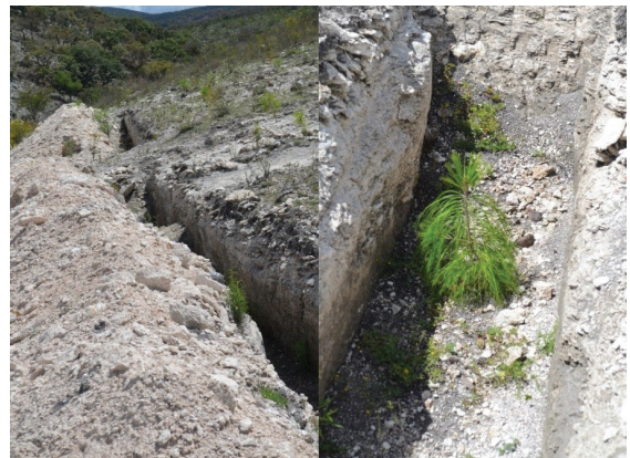
Figura 3. Zanjas de infiltración en San Martín Palo Solo. Junio de 2012.
