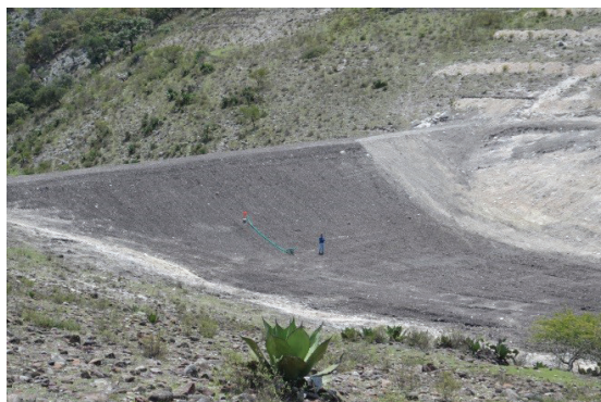
Figura 2. Represa de tierra compactada en San Martín Palo Solo. Junio de 2012.
