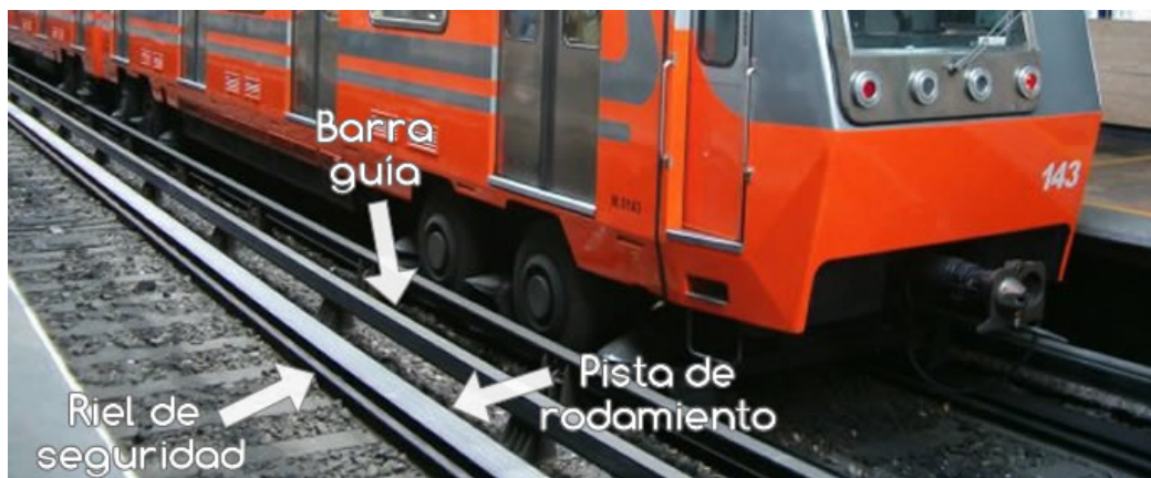
Figura 8. Elementos de las vías del Metro.
