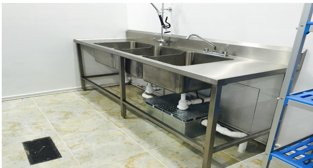
Figura 29. Ampliación del espacio de lavado
